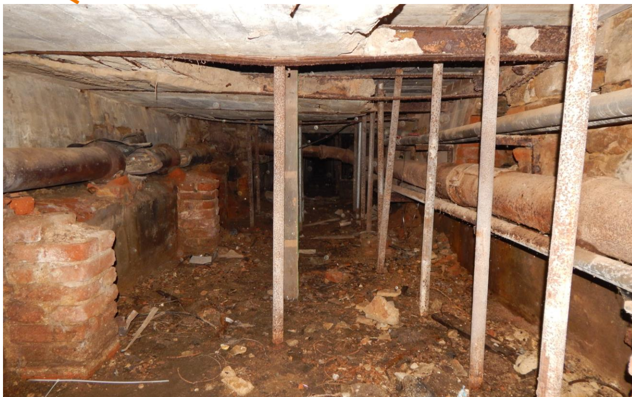
Obr. 05 – Stávající ŽB strop kanálu do ocelových traverz. Rozšíření zdi a zděné piličky pro uložení kameninového potrubí vlevo. Vpravo pak potrubí na ocelových konzolách.
