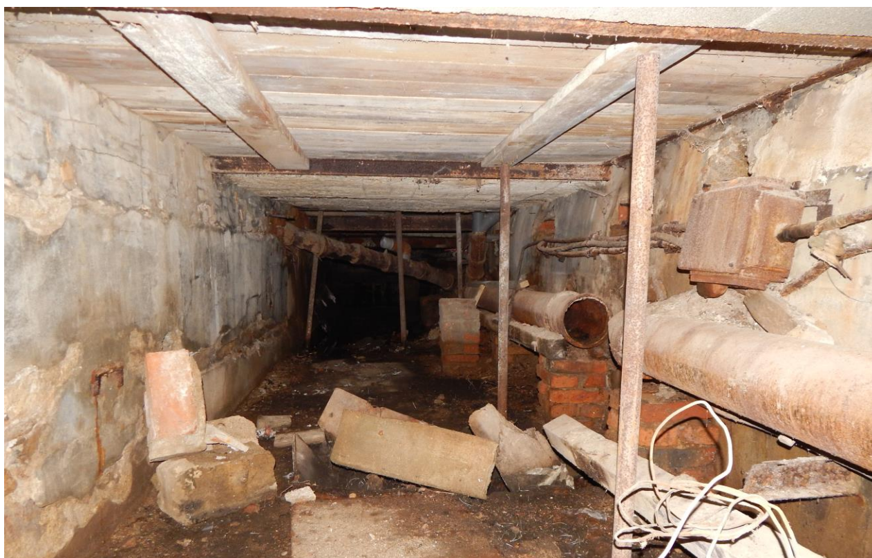
Obr. 08 – Litinové potrubí na cihelných pilířcích, pozůstatek elektroinstalace.
