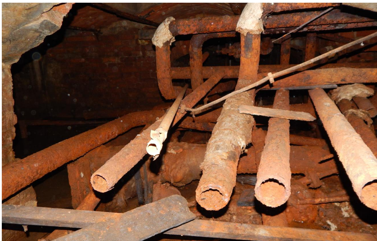
Obr. 06 – Pozůstatek ocelového potrubí v ukončení velkého kanálu pod atriem.
