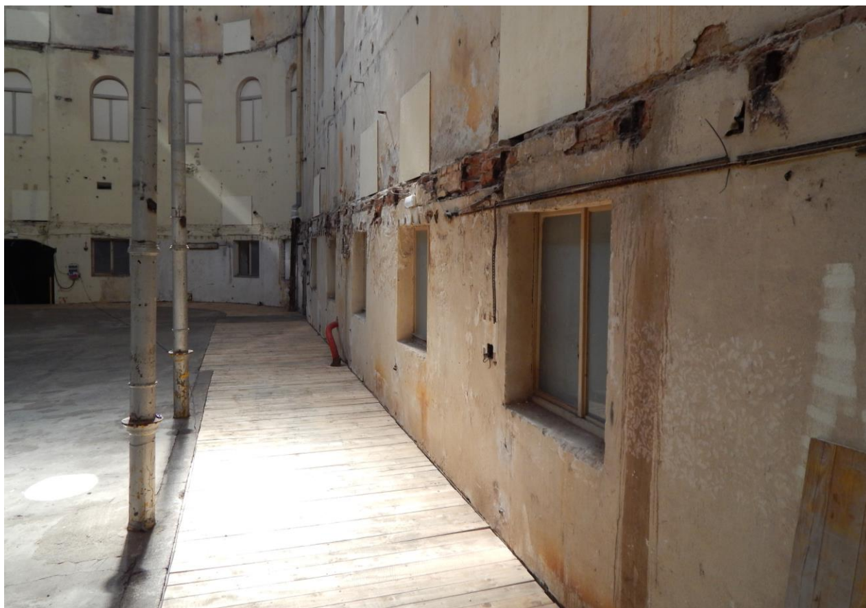
Obr. 04 – Kamenné kvádry osazené na koruně zdiva kanálu. Provizorní dřevěné zastřešení kanálu.
